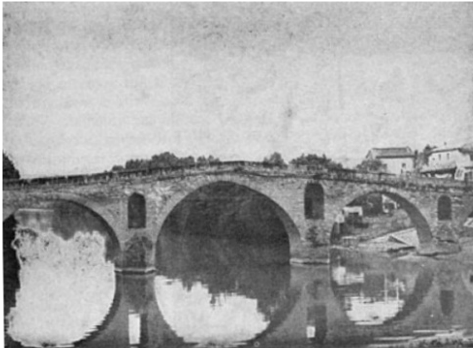
Puente la Reina: el puente de los peregrinos tendido cerca del antiguo vado que guardaba una casa de templarios. (Foto Col. del autor).
